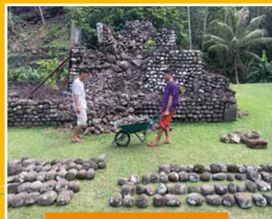
Rangement et triage des pierres effondrées
